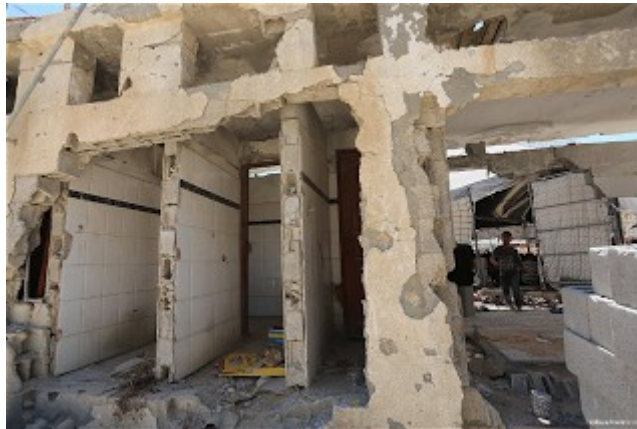
Une mosquée endommagée par les frappes aériennes israéliennes.
